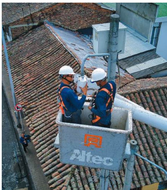
Instalación de las cámaras de seguridad Fuente: Alcaldía Municipal de Cajicá
