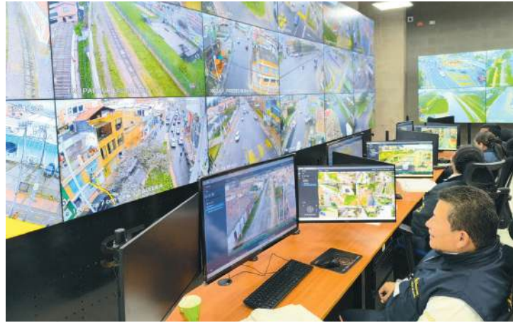
Cuarto de cámaras
